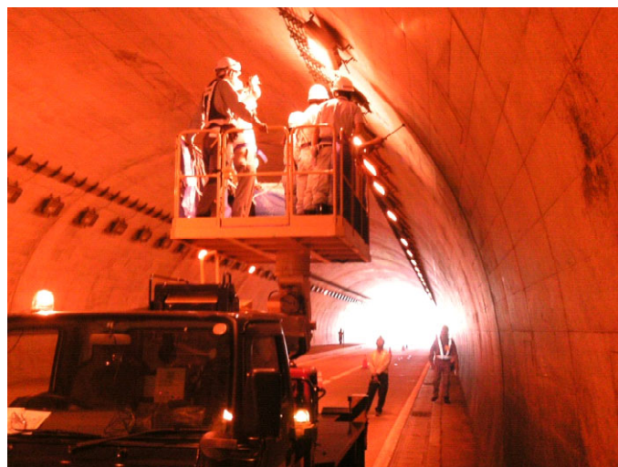
写真4 高所作業車による近接目視点検講習
