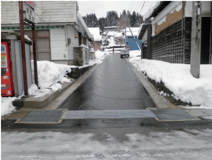
写真4 積雪約70cmの消雪状況
