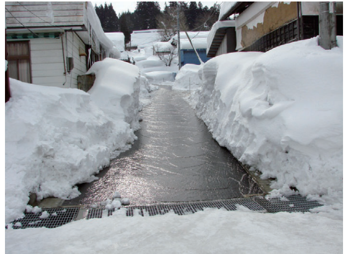
写真5 積雪約200cmの消雪状況
