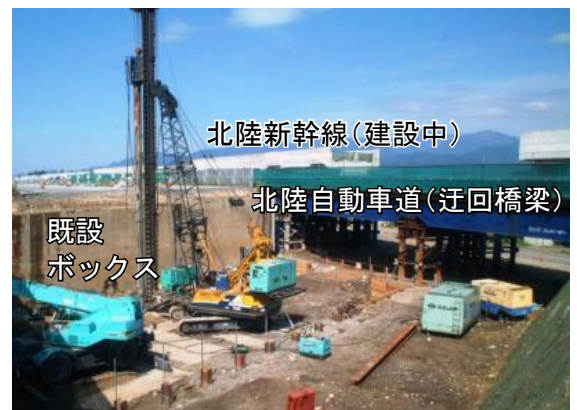
新設ボックスの施工
