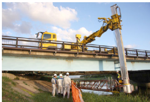
高校生による橋梁点検体験
