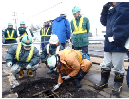
現地点検状況
