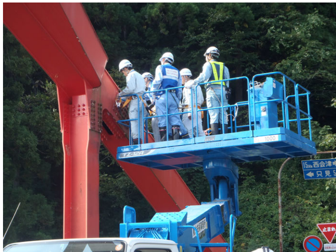
調査状況（リフト車を用いた近接目視）
