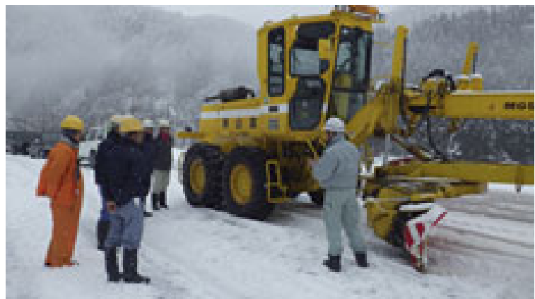
除雪オペレータ実地研修の様子
