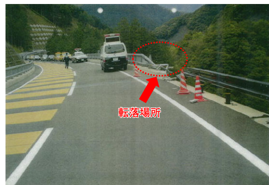
事故現場状況写真
