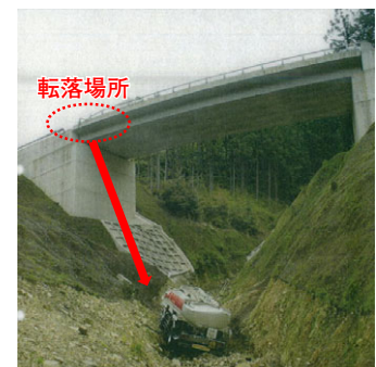
タンクローリー転落状況
