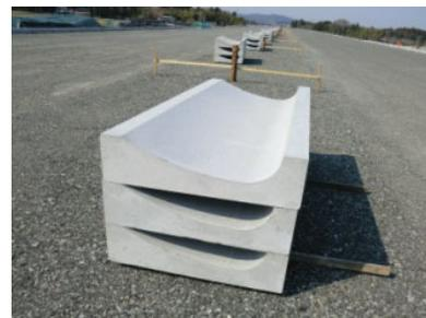
写真－9 コンクリート二次製品の使用
