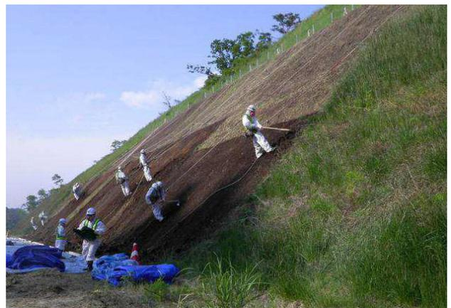
写真－1 切土のり面部の除染工事状況（植生基盤除去）
