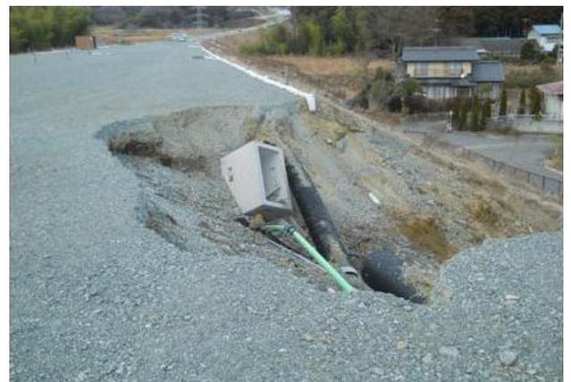
写真-3 盛土のり面損傷状況
