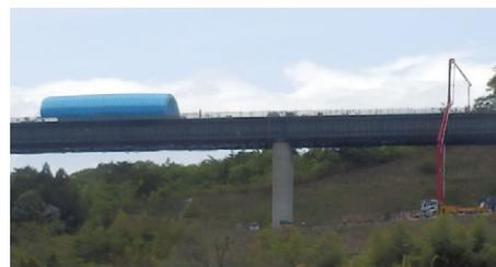
写真－10 仮設屋根設備の例（エアドーム式）
