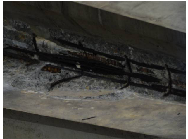
塩害による劣化損傷例
