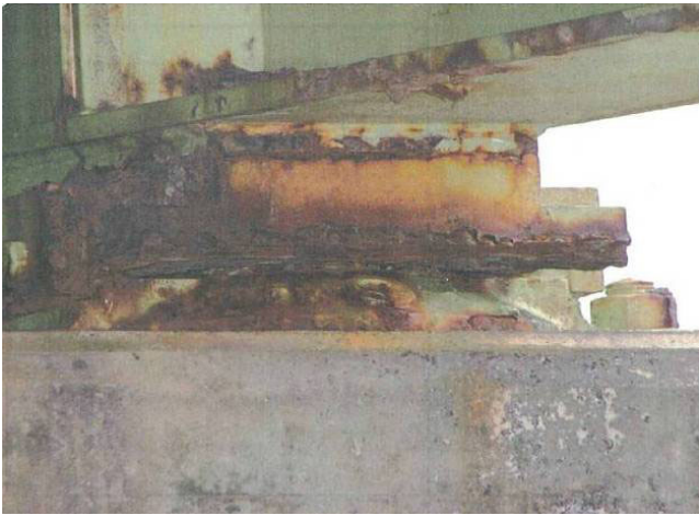
塩害による劣化損傷例
