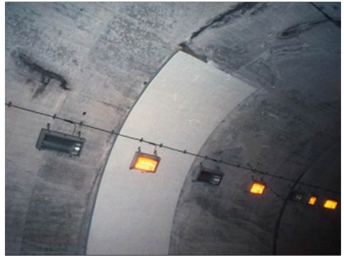
トンネル補修状況
