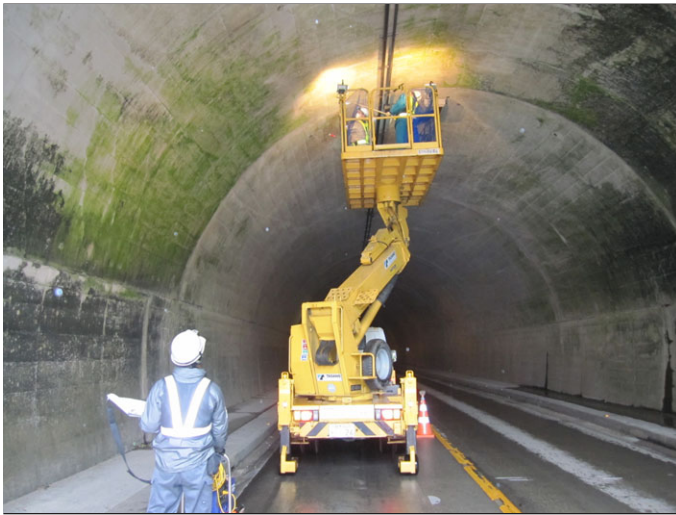
トンネル点検状況
