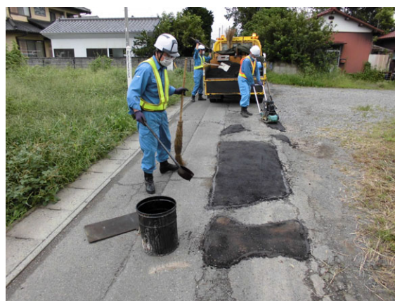
道路補修センター職員による点々補修
