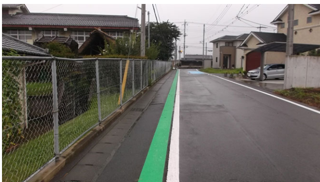
通学路安全対策の例（グリーンベルトの設置）
