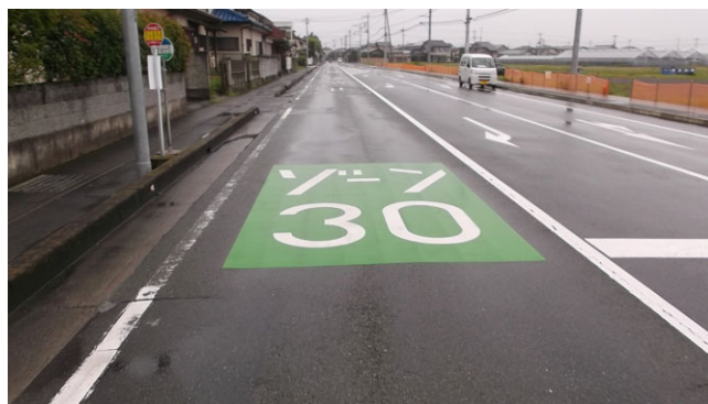
ゾーン 30 対策工事
