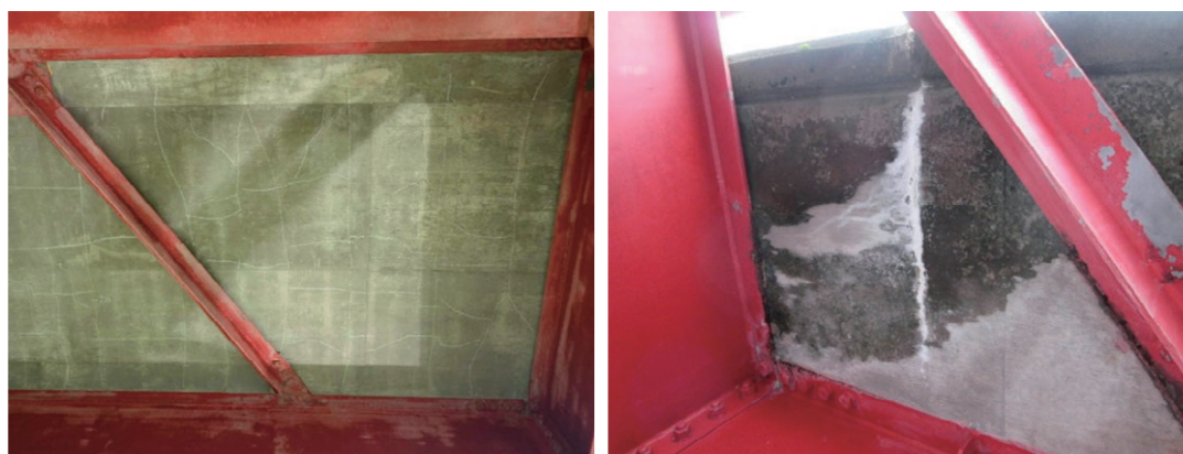
写真－11 床版・舗装
