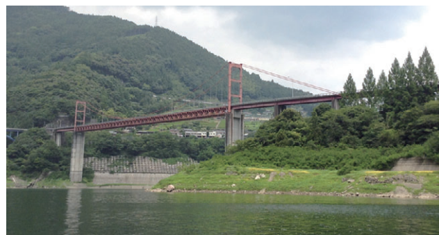
写真-1 大渡ダム大橋全景
