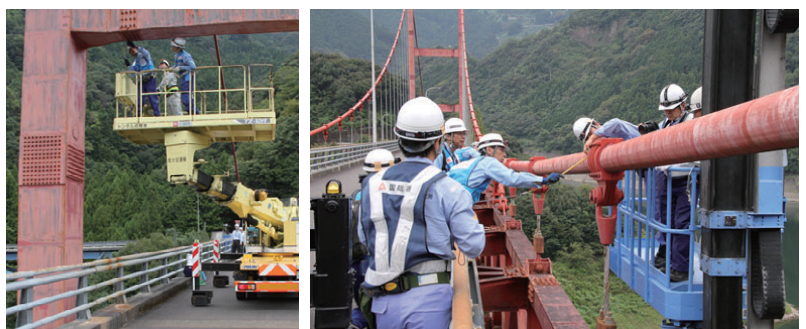
写真-3 直轄診断状況
