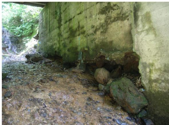
写真-1 下部工の洗掘
