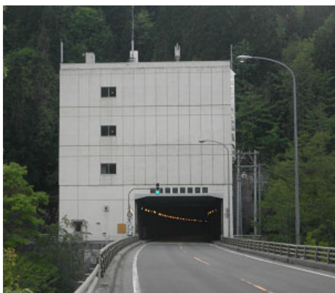
▲写真-1 みちのくトンネル七戸側換気所
