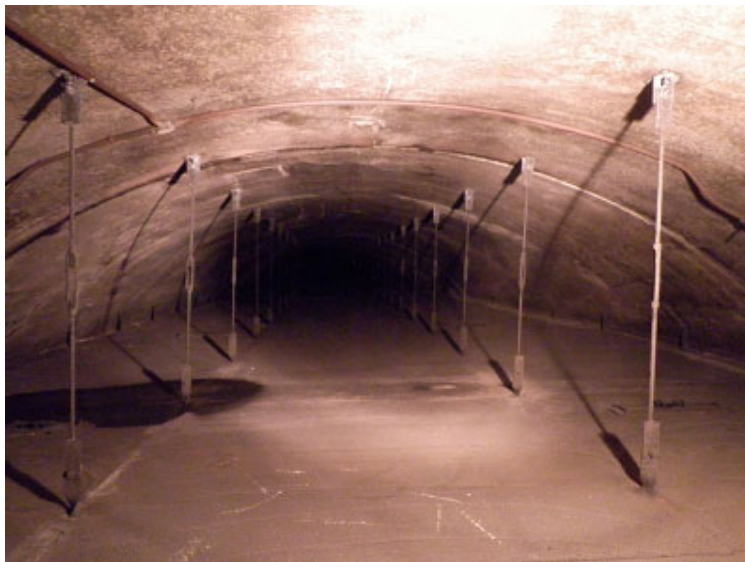
▲写真-2 天井板撤去前の状況(上)
