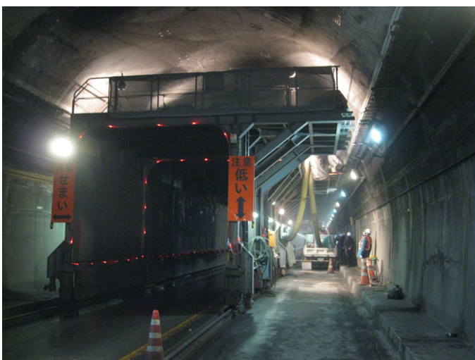
▲写真-4,5 鋼製プロテクター
