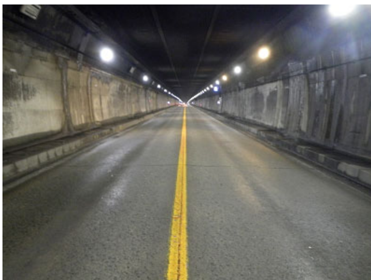
▲写真-3 天井板撤去前の状況(下)
