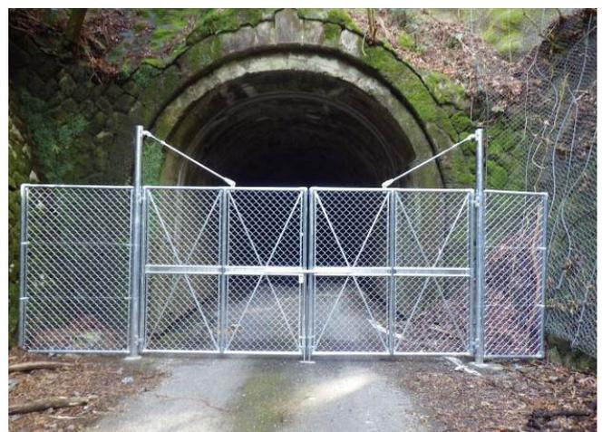
昭和20年に建設され築70年の逢坂隧道。昨年の定期点検で、トンネルが閉塞される恐れのあることが判明し、判定Ⅳの結果に伴い、現在通行止めを行っている。
