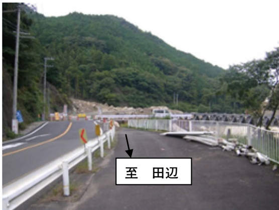
平成 24 年 10 月 1 日供用 仮設道路完了後の国道 311 号 (田辺市中辺路町真砂地内)
