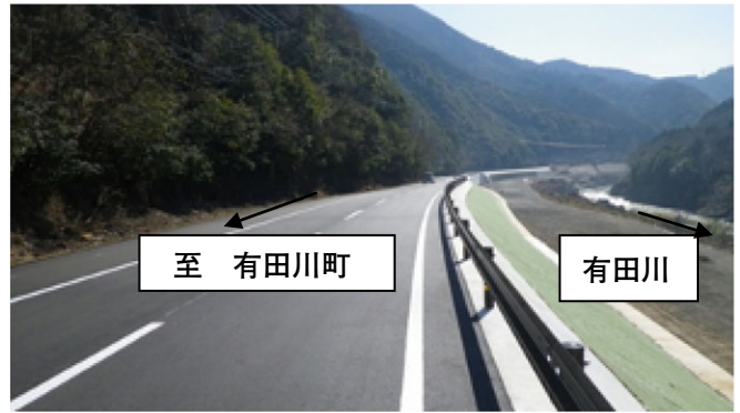
復旧対策後の一般県道たかの金屋線 (日高川町高津尾地内)
