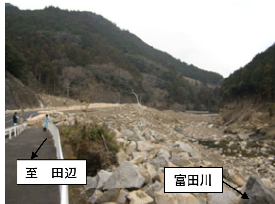
平成 23 年 10 月 4 日供用 応急仮設道路完了後の国道 311 号 (田辺市中辺路町真砂地内)
