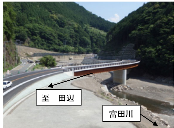
平成 27 年 3 月 27 日供用 道路災害復旧完成後の国道 311 号 (田辺市中辺路町真砂地内)
