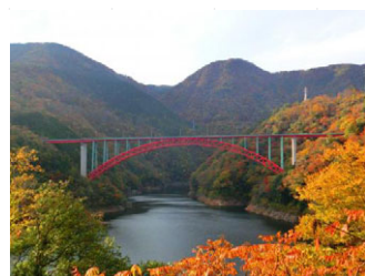
瀧山峡大橋L=369m【アーチ橋】 (1997年完成)
