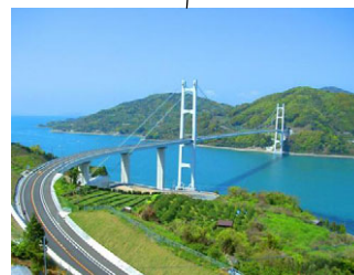
豊島大橋L=903m【吊橋】 (2008年完成)
