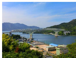
早瀬大橋L=623m【トラス橋】 (1973年完成)
