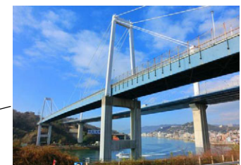
尾道大橋L=386m【斜張橋】 (1968年完成)
