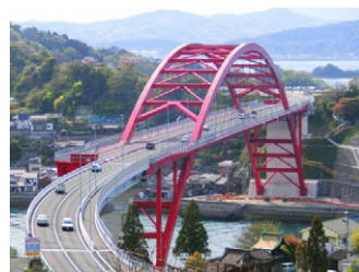
第二音戸大橋L=492m【ニルノボレ橋】 (2013年完成)
