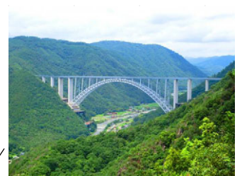
広島空港大橋L=800m【アーチ橋】 (2011年完成)
