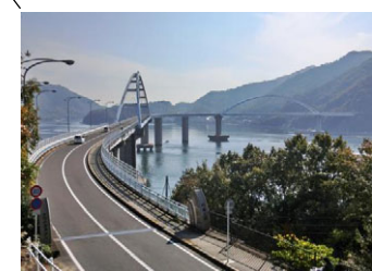
内海大橋L=832m【ニルノボレ橋】 (1989年完成)
