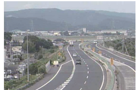
写真-5 映像による情報収集 (CCTVカメラ)
