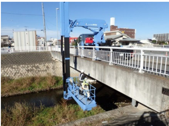
橋りょう定期点検状況
