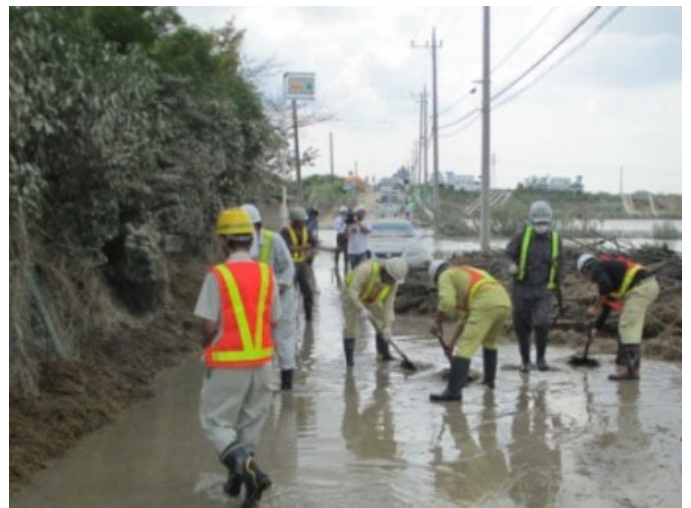
写真－5 レッカー移動前土砂等除去作業
