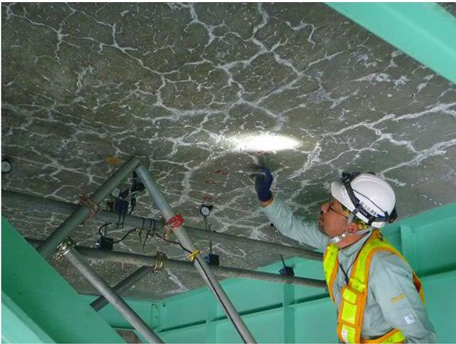
道路橋（床版）の損傷状況
