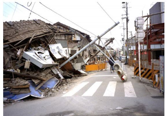
写真 1. 阪神・淡路大震災で倒壊した電柱 (出典：国土交通省ホームページ)
