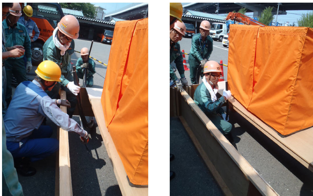
写真8 関西電力㈱による柵サイズ及び機器の仕様見直し（コンパネ模型による作業性確認）
