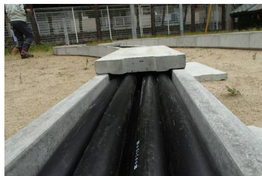
写真7 電線管理者による小型ボックスサイズの検証
