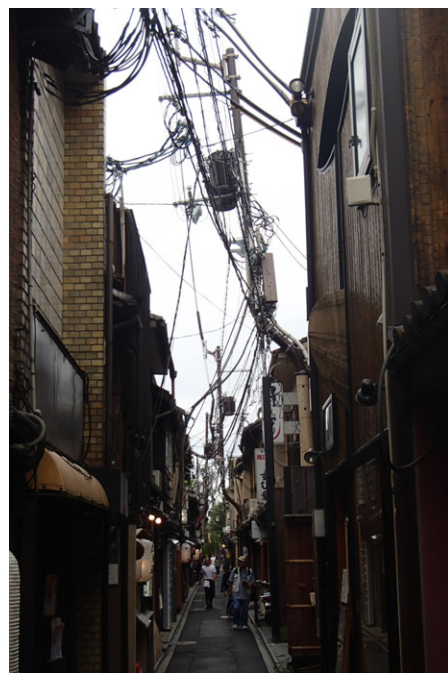
写真4 先斗町通の電柱・電線類
