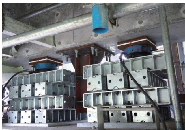
写真－7 並柳橋 応急復旧状況
