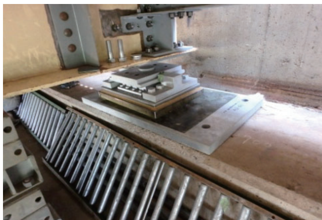
写真－9 木山川橋 支承復旧状況
