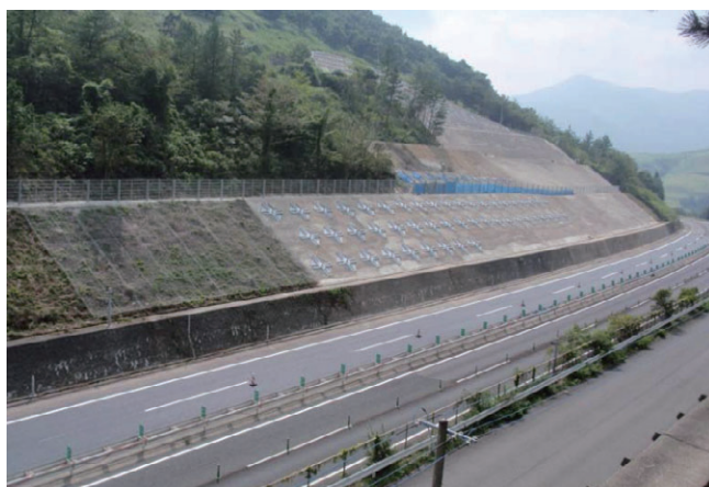
写真－11 由布岳 PA 付近復旧工事完了
