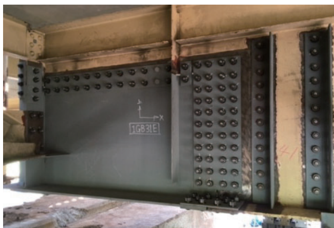
写真－10 木山川橋 桁損傷復旧状況
