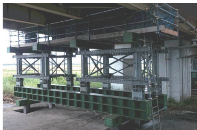
写真-5 木山川橋 応急復旧状況
