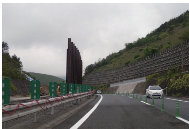
写真－6 由布岳 PA 付近 応急復旧状況
