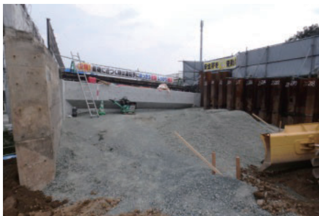
写真－8 益城 BS 付近 盛土のり面復旧状況
