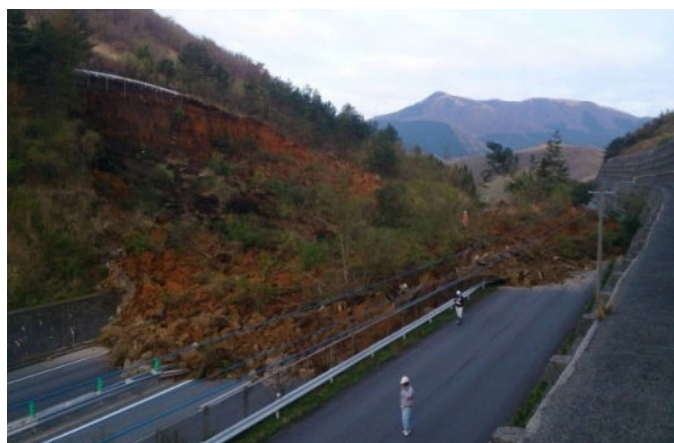
写真－2 由布岳 PA 付近 切土のり面土砂崩落
