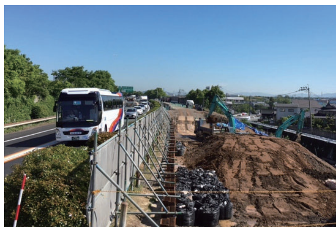
写真-4 益城 BS 付近 盛土のり面 応急復旧状況
