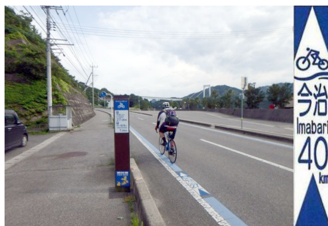
写真-5 ブルーラインと路面表示ピクトグラム
