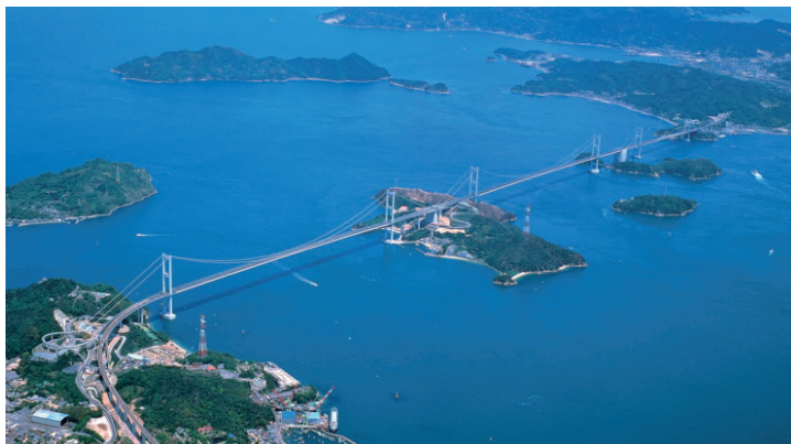
写真－1 今治と大島を結ぶ来島海峡大橋
