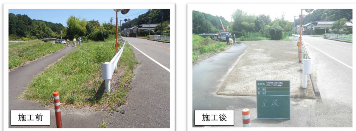
【写真1 県道でのチップ材マルチング試験施工例】
