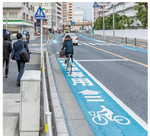
写真-4 矢羽根・ピクトグラムが整備された自転車専用通行帯（国道17号・さいたま市）
