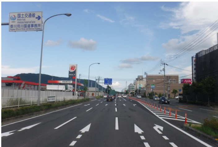
現地写真（福岡町二丁目交差点）
