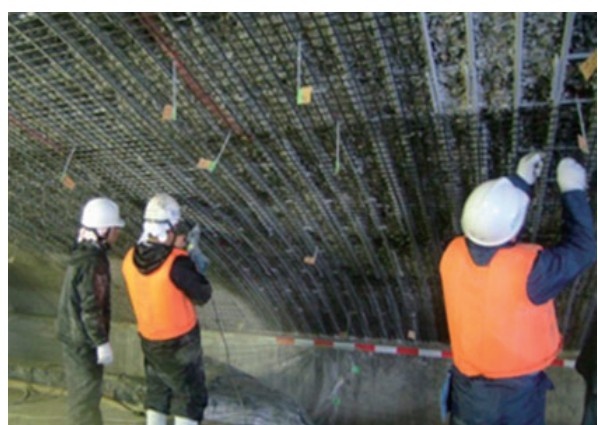
▲ 大規模修繕事業 補修状況
