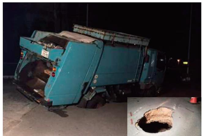
下水道の老朽化による道路陥没
