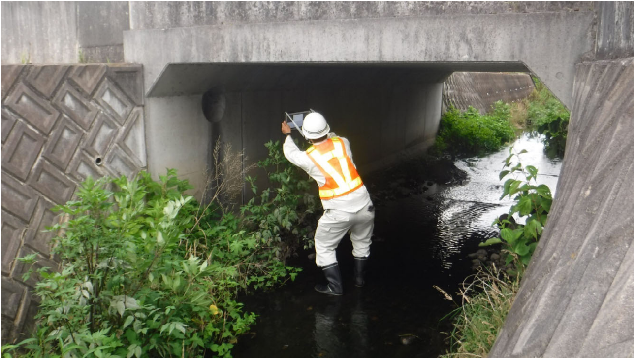
タブレットを用いて点検している様子
