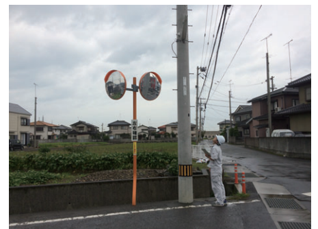
道路付属物点検状況（道路照明灯）
