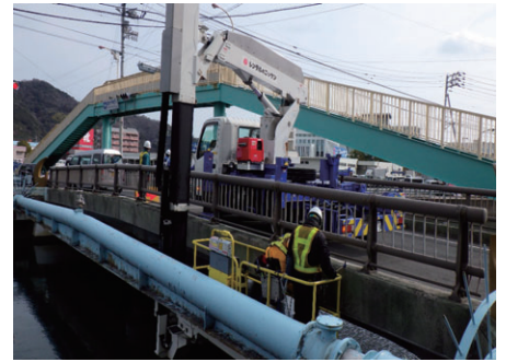
橋梁点検状況（長寿命化修繕計画）
