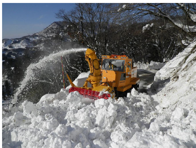
写真2 除雪・雪底処理状況（新潟県上越市）
