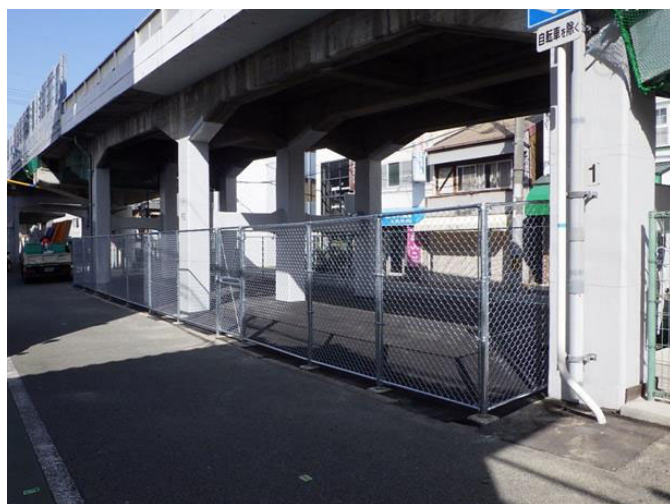
耐震補強工事後の状況
