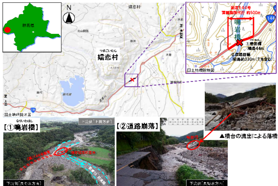
図－4 位置図・被災状況
