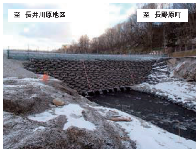
写真－7 緊急迂回路渡河部の盛土状況
