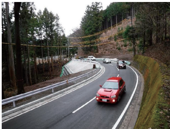
写真-3 復旧状況
