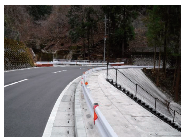
写真-4 復旧状況
