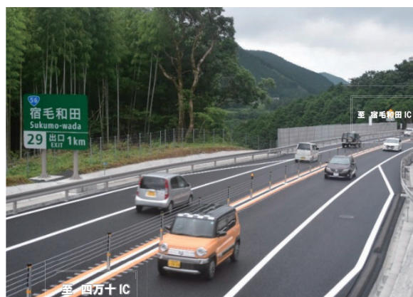
開通後の交通状況（宿毛和田 IC 付近）
