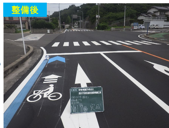
矢羽根設置による自転車走行環境整備
