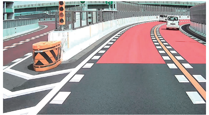
写真-4 交通安全対策の一例（カラー舗装）
