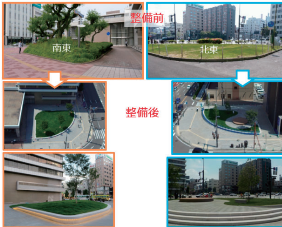
写真－5 交差点広場（東）整備状況
