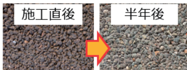
写真ー1 脱色アスファルトの変化
