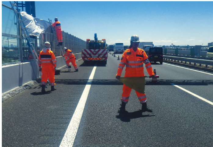
写真-2 橋梁高架上での監視員
