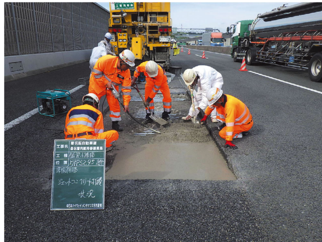
写真-3 橋梁高架上での舗装補修工
