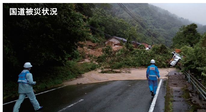
(八代市坂本町被災状況調査)
