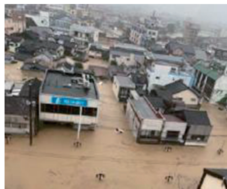
（7/4 浸水状況：人吉市街部）
