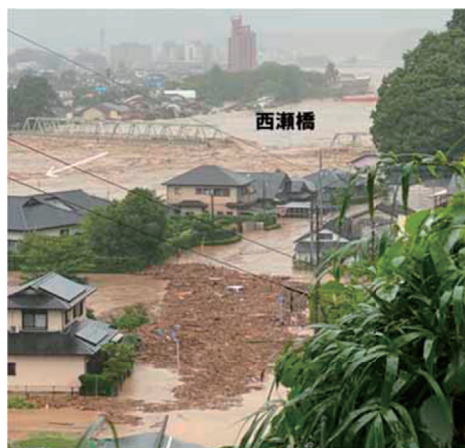
(7/4 西瀬橋流失：人吉市)
