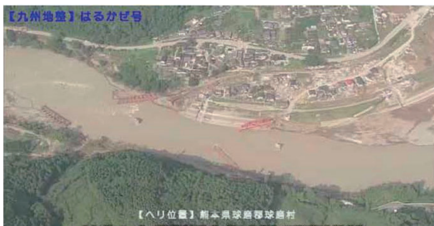
(7/4 流失した鉄道橋と相良橋：球磨村渡)
