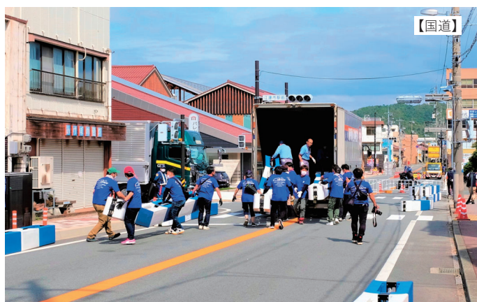
写真－5 緩衝材撤収状況
