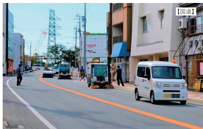
写真－6 路面清掃状況
