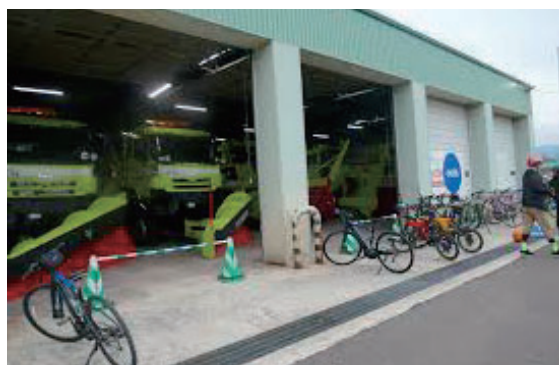
■除雪ステーションには除雪車両を格納する大型車庫が設置されている
