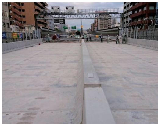
図-6 UFC 床版の設置状況
