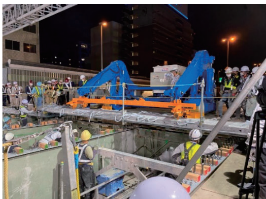
図-5 UFC 床版の架設状況
