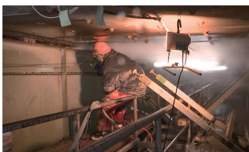
図-7 ウォータージェット工法の施工状況
