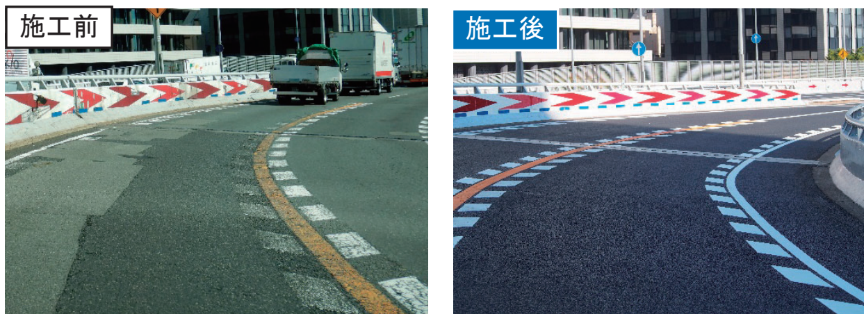
図-10 舗装・伸縮継手（ジョイント）の補修状況
