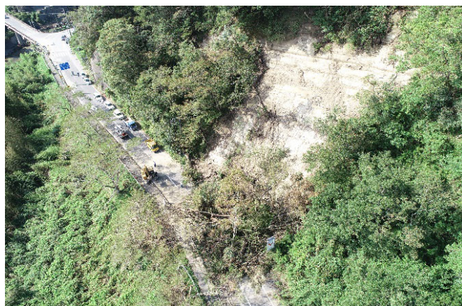
県道大多喜君津線（法面崩落）
