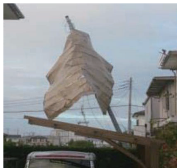
飛来物による電柱倒壊（東金市）
