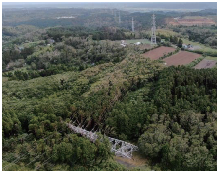
鉄塔設備の倒壊（君津市）
