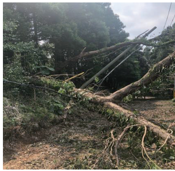
倒木による電柱倒壊（四街道市）
