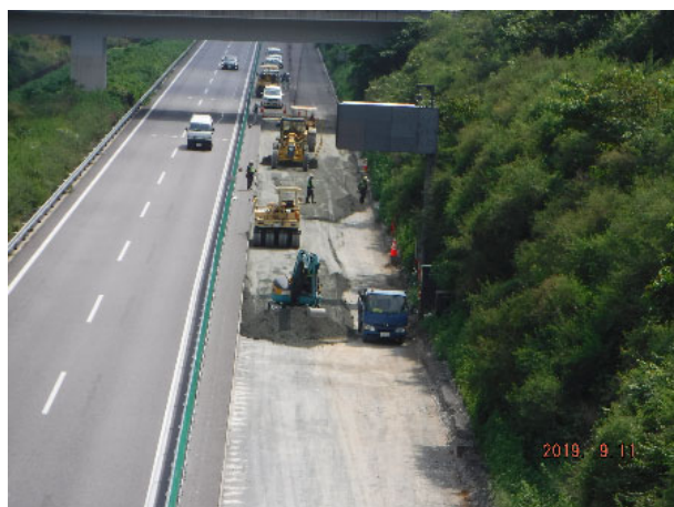
写真 -1 狭小なヤードでの施工状況
