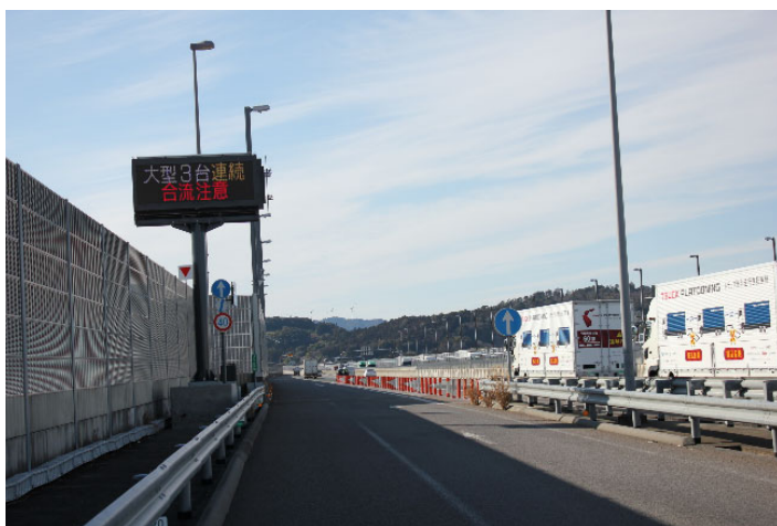
写真-4 合流支援システム（浜松浜北 IC（下り））
