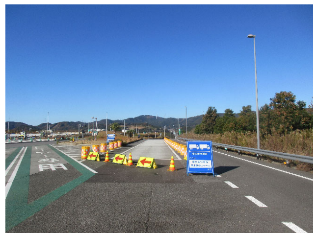
写真-5 隊列分離・形成ヤード（浜松 SA（下り））
