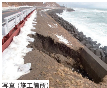
写真（施工箇所）
