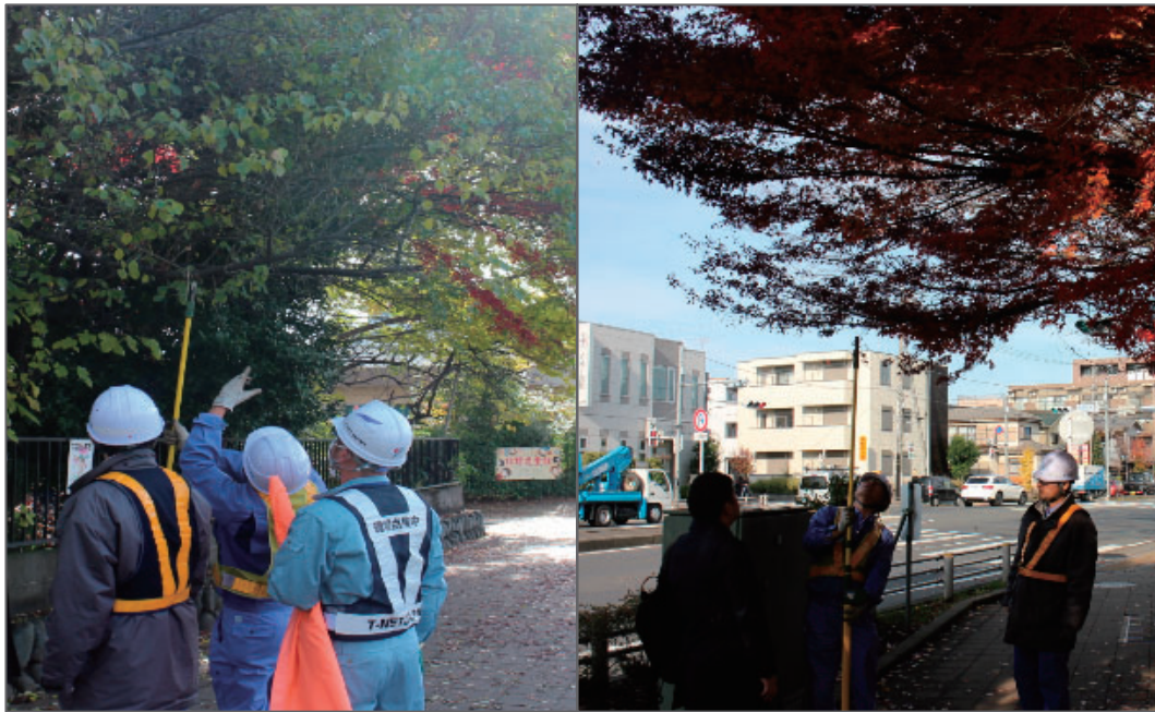
写真－2 除去前の国道側越境樹木の計測
