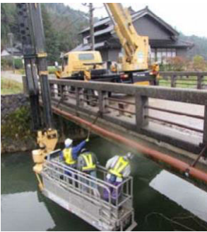
図6 橋梁点検風景
