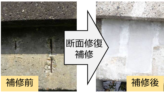
図8 橋梁主桁の補修工事の例
