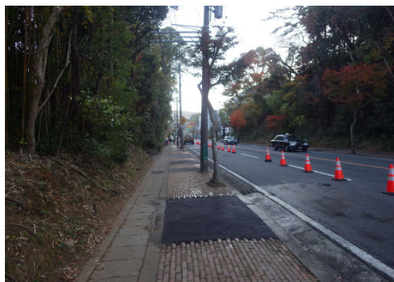
写真 -5 撤去作業完了の様子
