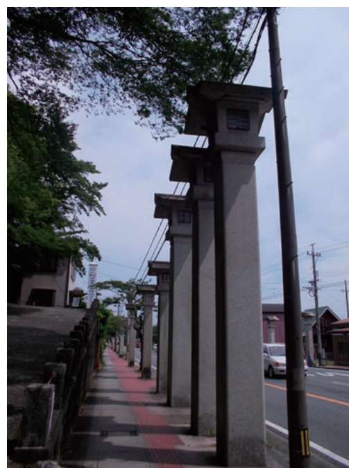
写真-1 石灯籠の設置状況(約6m)
